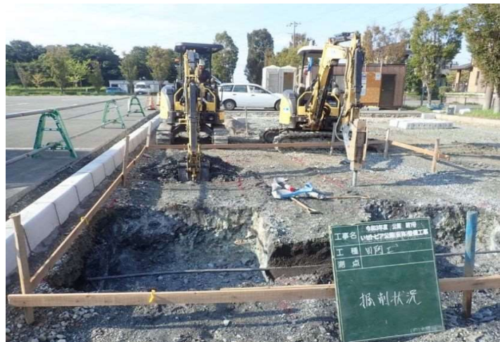
施工状況 (基礎部)
