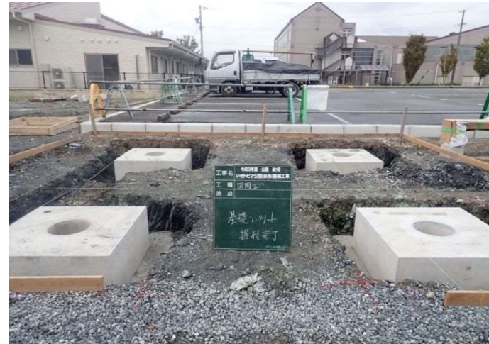
施工状況 (基礎部)
